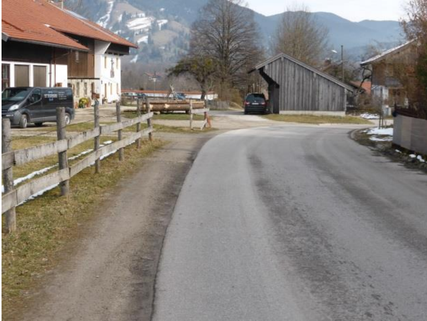
Abbildung 3: Längentalstraße in Höhe Grundstück Kaltenhauser
