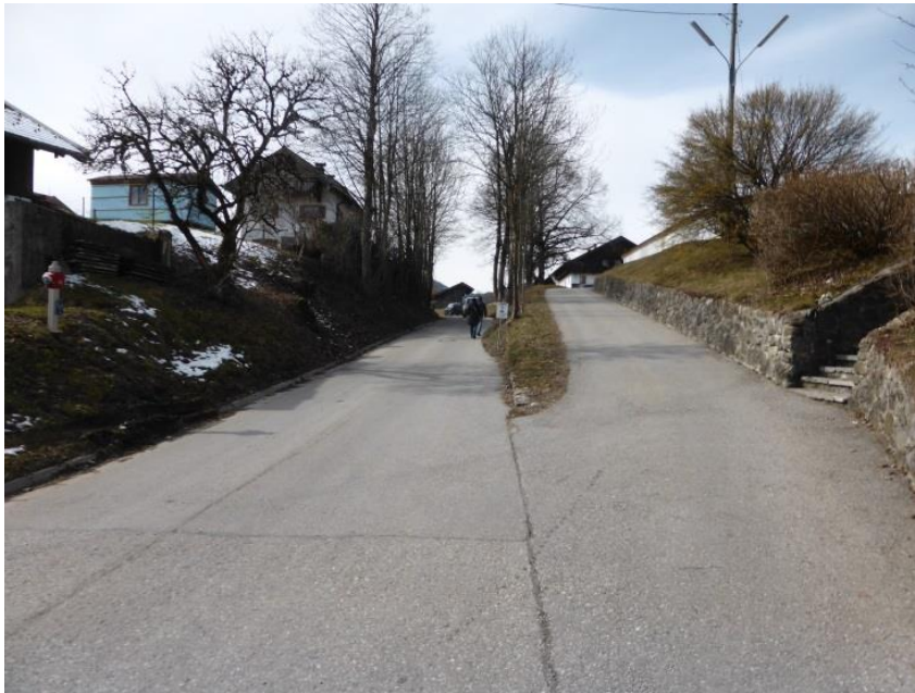
Abbildung 1: Engstelle Längentalstraße im Bereich Kirche (Blick nach Westen)
